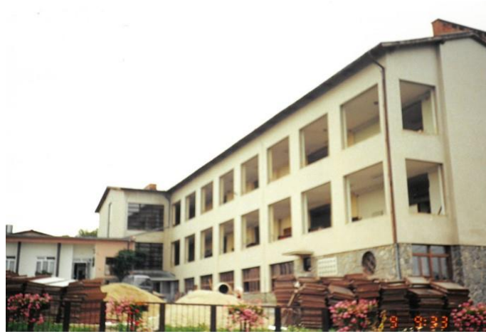
Šola v času prenove
